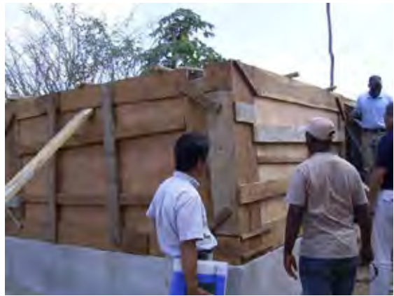
建設中の雨水貯水タンク (ナマンジャビラの小学校)
