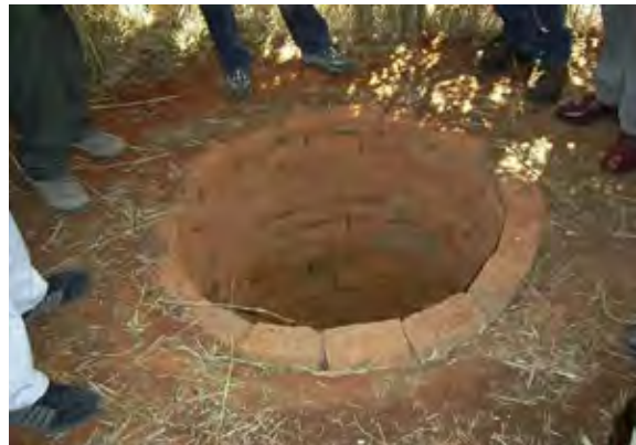
建設中のモデルトイレ
