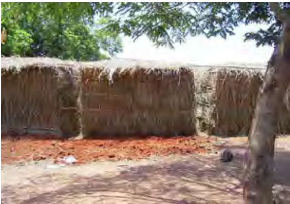
デモンストレーション用トイレが この中に建設されている
