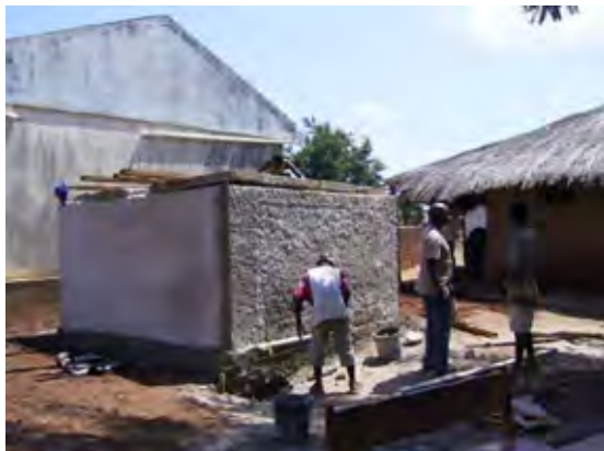
アルベネフィカの小学校で建設中の雨水貯水タンク
