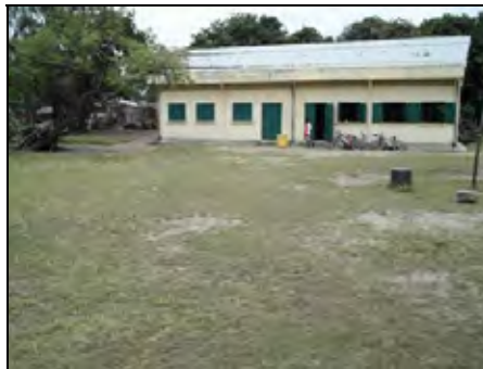
中学校に貸している校舎の前面が建設用地。2階建ての6教室増設を要請。
