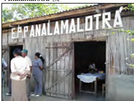
Analamalotra 校の既存狭小仮設教室棟。
