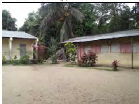
敷地一杯に既存校舎・教員住居が配置され、建設用のアクセスが確保できない。
