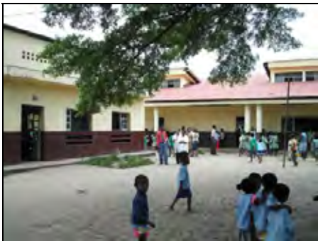
既存教室はハイサイドライト(高窓)と青色の内壁で、明るく涼しげな室内である。
