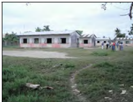
写真内既存4校舎を「マ」国側で取り壊し、一部/全部2階建て20教室の増設を要請。
