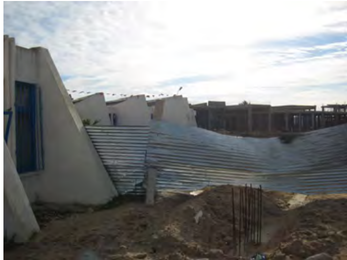
拡張工事中のバイオテクノロジー研究センター
