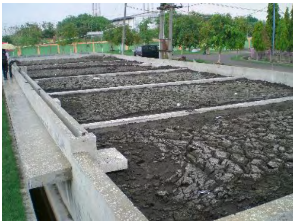
(6) 天日乾燥床、汚泥乾燥地 (写真 17~19)
