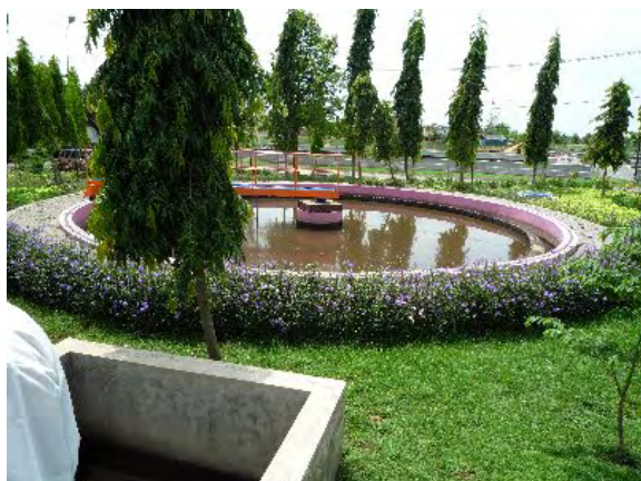
(4) 最終沈殿池（写真 12～13）
