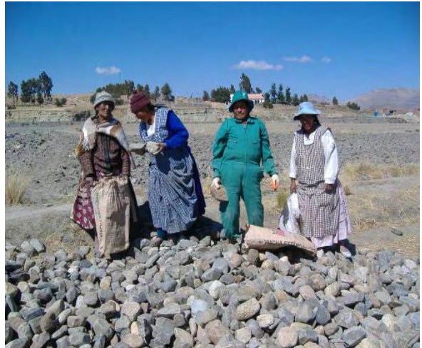
灌漑水路工事では農民が労働力を提供する
