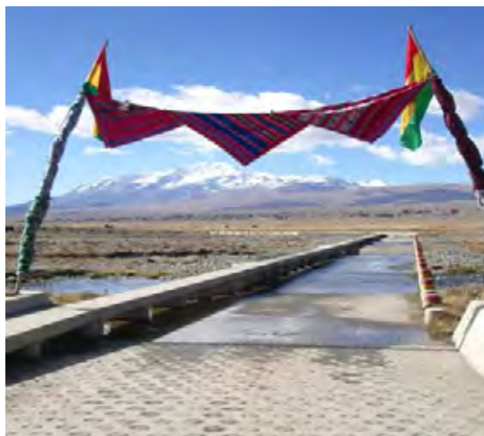
第1期工事で建設された潜水橋 アイマラの風習では道に織物 (アワヨ)を掲げて客人を歓迎する。
