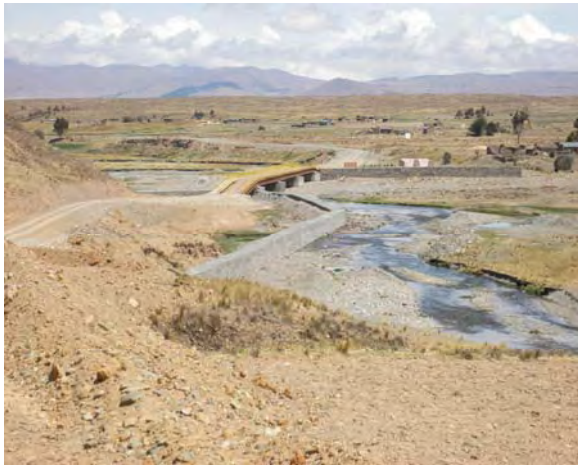
見返り資金で建設された橋梁
