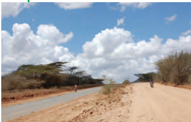
ナイロビ(ケニア)ーアルーシャ(タンザニア)間の道路補修現場
