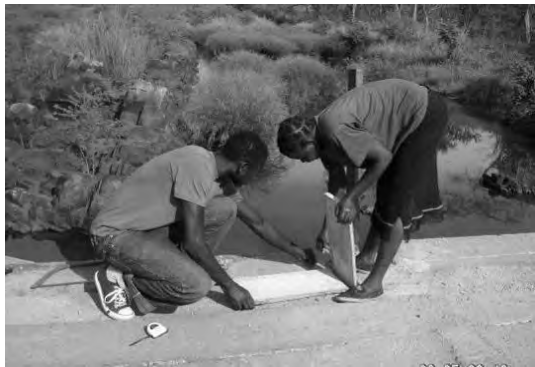
Gulu 郊外の川にかかる橋に、手すりを設置する工 事の様子。この橋には、これまで手すりがなかつ た。Gulu 県
