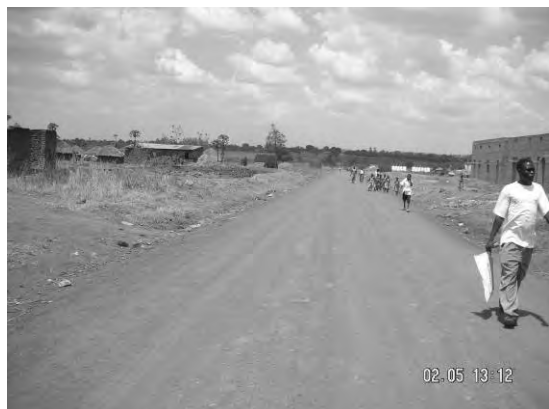
Periodic Maintenance が進行中の国道 Kitgum-Lira 間の Pajule 近く。【右】工事に使用されている建設機械 (グレーダー)。UNRA-Kitgum によると、Periodic Maintenance 工事の人力コンポーネントは 15% 以下。Culvert installation (600mm が 3 本、900mm が 8 本)、Gravel 仕上げ (100mm 厚) で構成される。Pader 県
