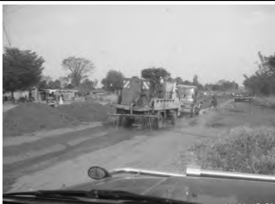
Periodic Maintenance 工事中の国道 Gulu- Attiak 間 (Attiak 寄り)。UNRA-Gulu によると、南スーダンにつながるこの区間は、地盤が軟らかく (soft soil)、仕上げの砂利層 (gravel) は 300 mm。Routine Maintenance は毎年行うことになっている、とのこと。Amuru 県
