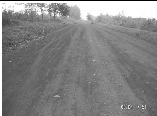
Routine Maintenance で grading が終わり、gravel がまかれた国道 Gulu- Attiak 間 (Gulu 寄り)。側溝・排水工事は、まだ行われていない。Amuru 県
