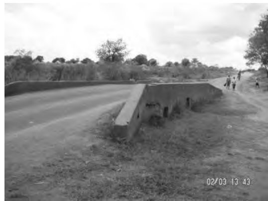
洪水時に道路下に水を通す Vented drift。 Kitgum 県
