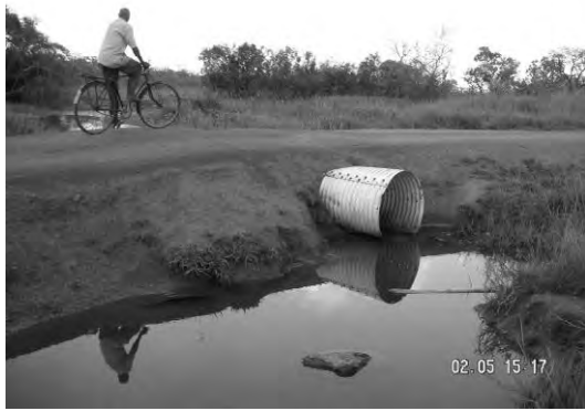
県道のカルバート橋。Pader 県
