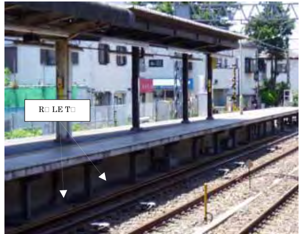
Hình 5 :Hàng cuộn cảm ứng mặt đất có tính năng đổi chiều tốc độ
