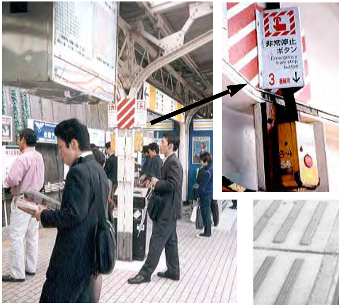
Ảnh 38.3 Nút ấn dừng tàu khẩn cấp
