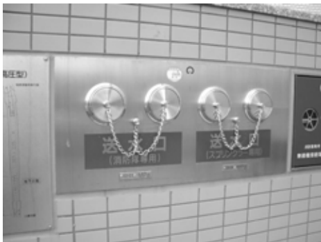
Ảnh 40.35 Ví dụ về cửa phun nước lắp vào cửa ra vào
