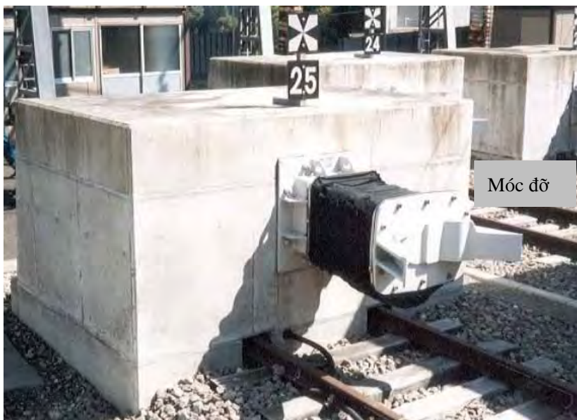
Hình 32.5 Thiết bị dừng tàu kiểu giảm xung thủy lực
