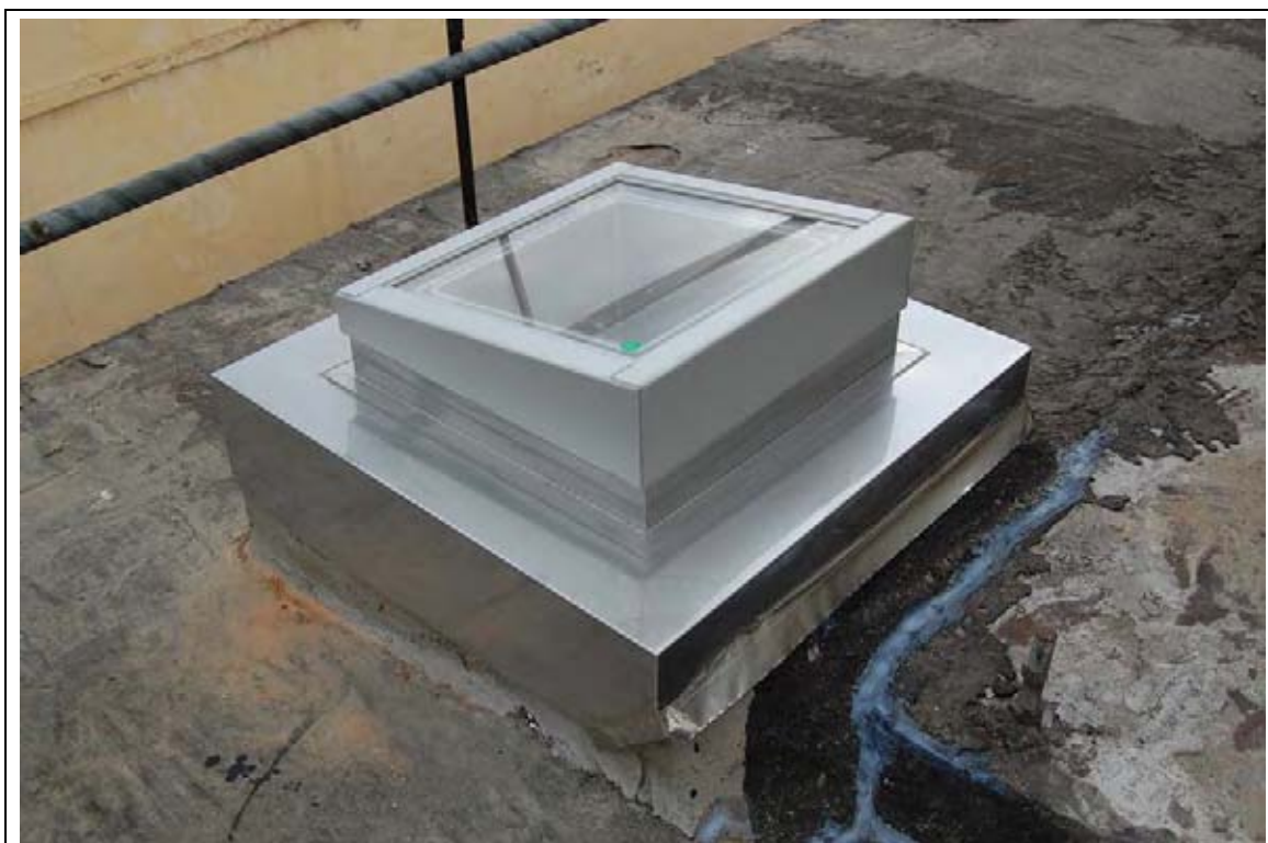
ウランバートル機材設置完成 : 2007 年 9 月 10 日
