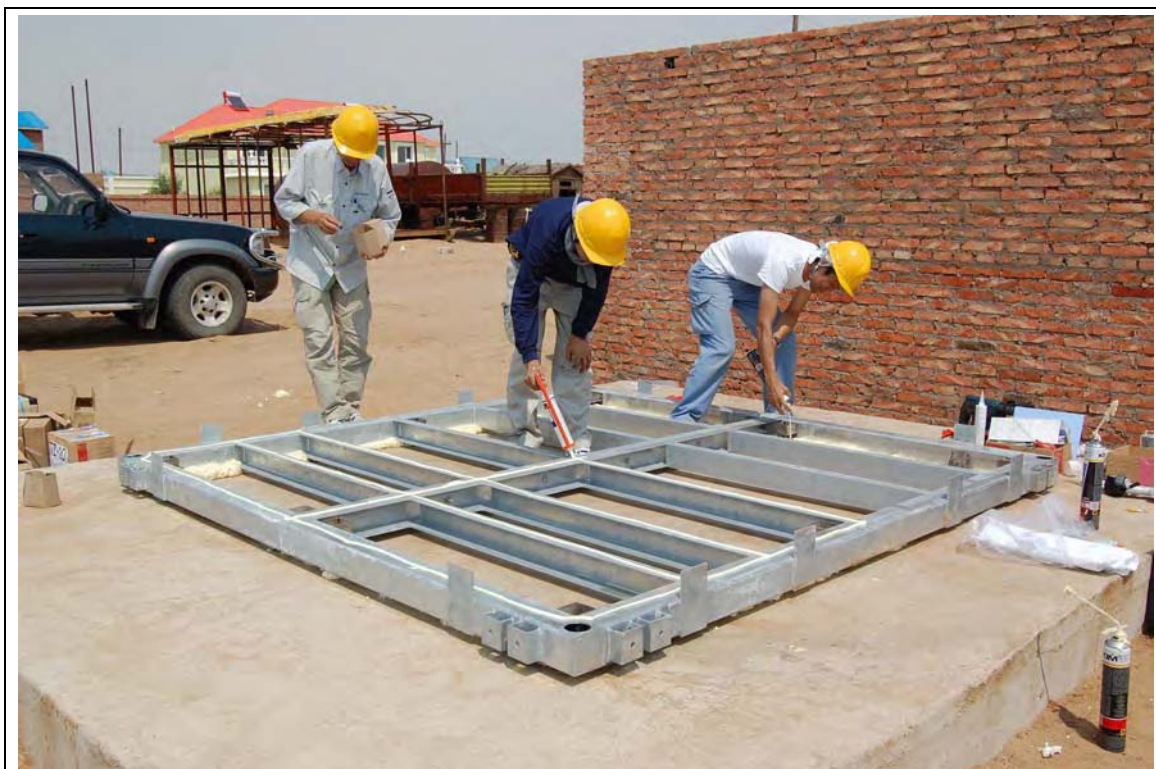
ザミンウッド作業（コンテナベース設置）：2007年8月11日
