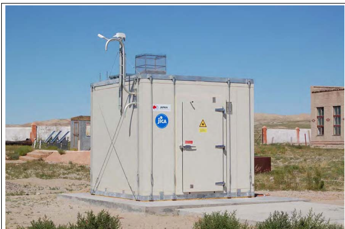
サインシャンド機材設置完成：2007年8月25日
