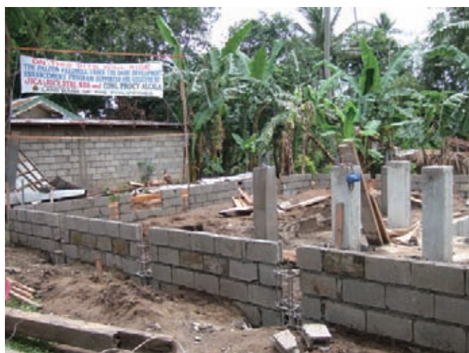
フィードミル移設予定地（建設中）
