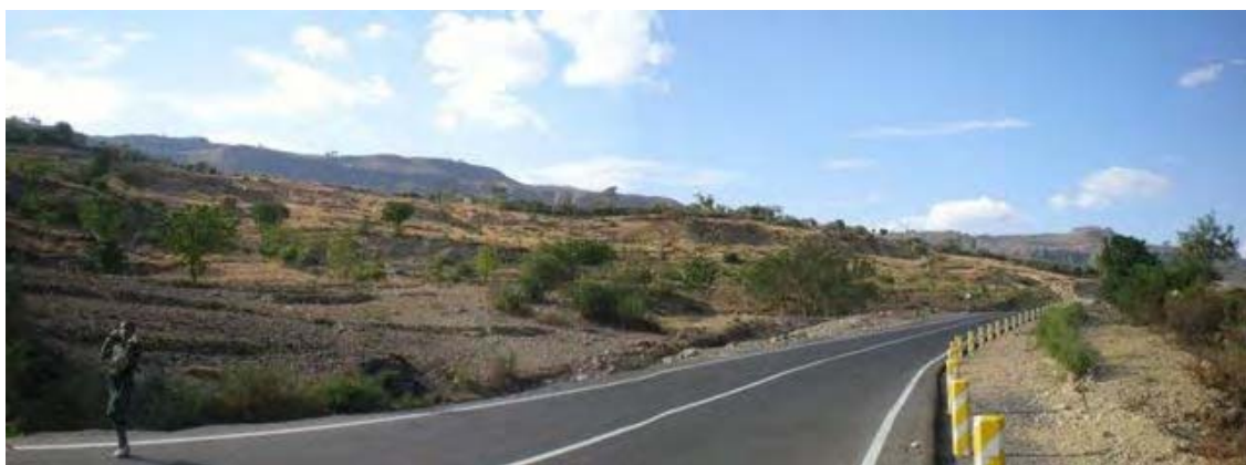
デジェン側斜面地すべり。Sta.26～28
