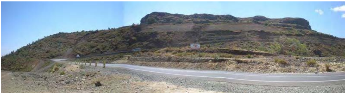
ゴハチオン側斜面地すべり。Sta.2～5全景及びSta.2上方斜面
