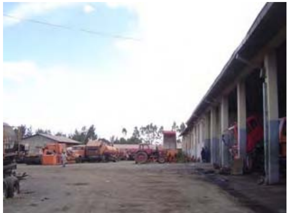
DRMC事務所併設の建機修理工場
