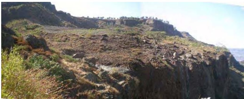
ゴハチオン側斜面地すべり。Sta.1付近
