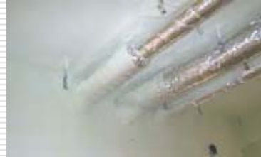
ダクト貫通部分
