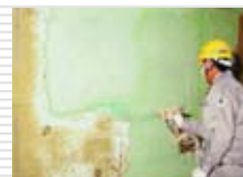
現場の施工例
