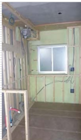
吹付後軸組施工
