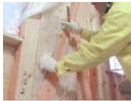
天井・床・壁等の改修
