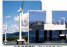
北海道厚岸町 (計12,000kW) 日本初の海上風力発電
