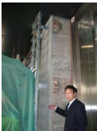
XPS+軽量鉄骨下地。通気層工法。
