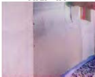
均しモルタル塗り
