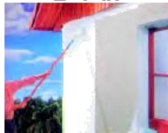
外壁仕上げ塗装
