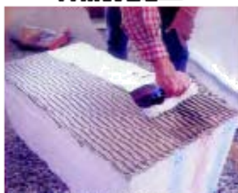
断熱ボードの線状接着
