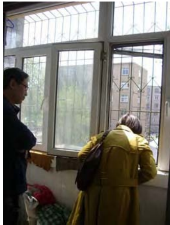
改修後の開口部
