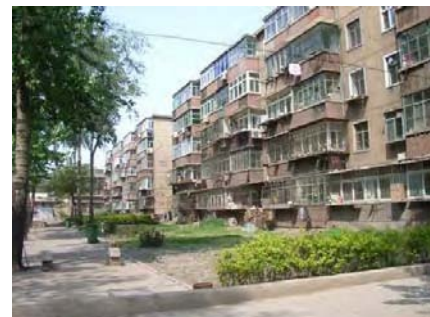
断熱改修を実施していない住棟
