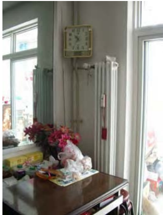
改修後新設したラジエーター
