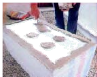
断熱ボードの点状接着
