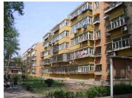
断熱改修を実施した住棟
