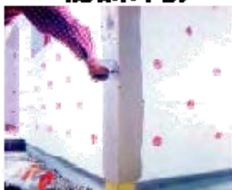
均しモルタル塗り
