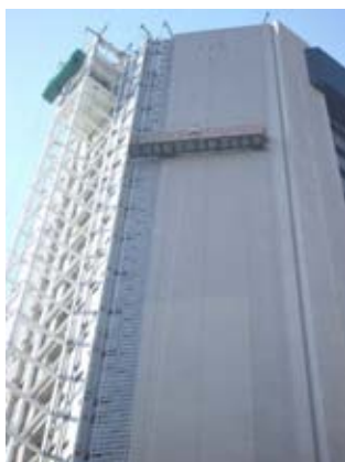
妻側の施工状況。シースルエレベーターと外装タイル施工中。
