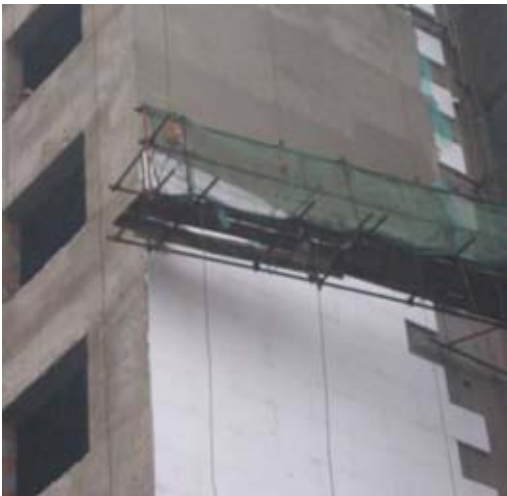
モルタル塗り
