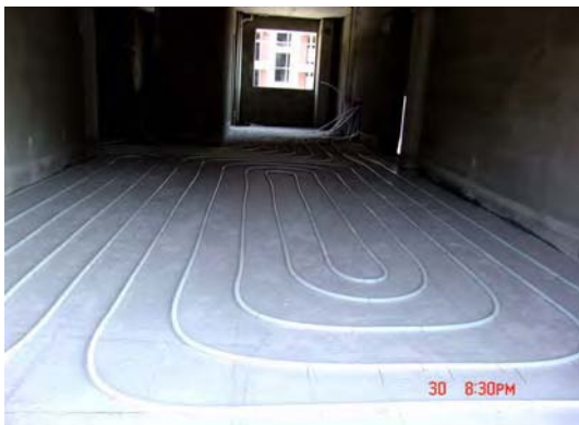
图 26 床暖房施工现场
