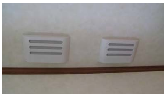
図45 湿度感知制御型自然換気口 3 Humidity-controlled Extract Unit (GHN) Aereco 社製, フランス
