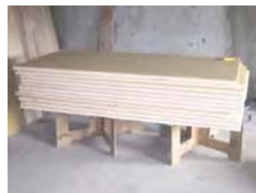
図 3.1.1.1-2 保温材の保管
