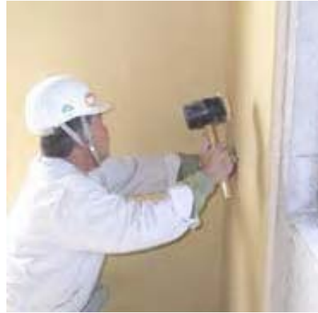
図 3.1.1.1-8 貼り付け、圧着
