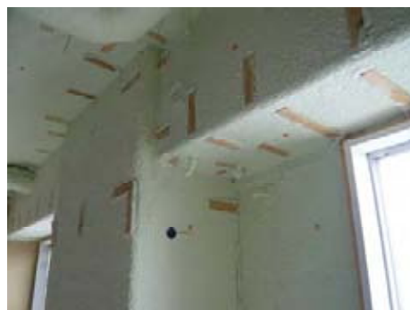
図3.1.1.2-3 吹付け作業後
