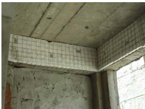
上：中国の内断熱の施工例
