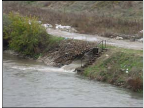
Point (D) Blvd Serbia, Bridge (Outlet of Sewerage, Right Bank)
