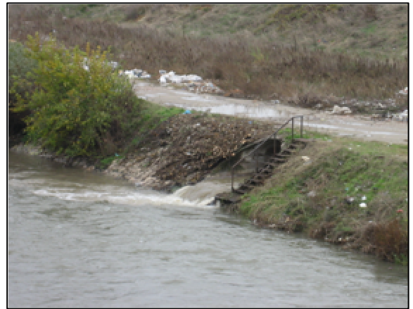
地点 D. Blvd Serbia, Bridge (右岸最大污水吐口)
