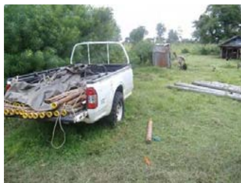
Mobilisation to the site
