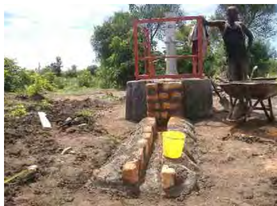
14. バケツ用台座および排水路を追加建設
