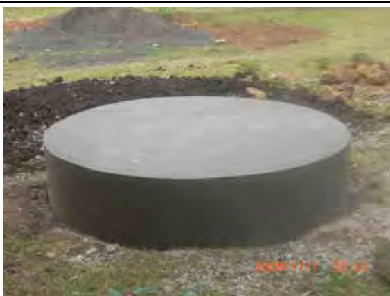
13. 貯水タンクの取り付け台の設置
