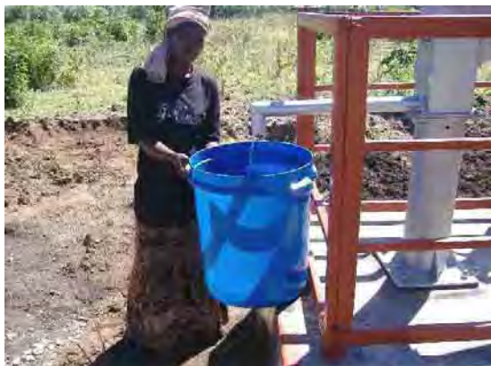
13. 完成した手すり・ポンプ
