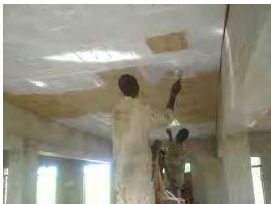
15. 内装のペンキ塗り工
