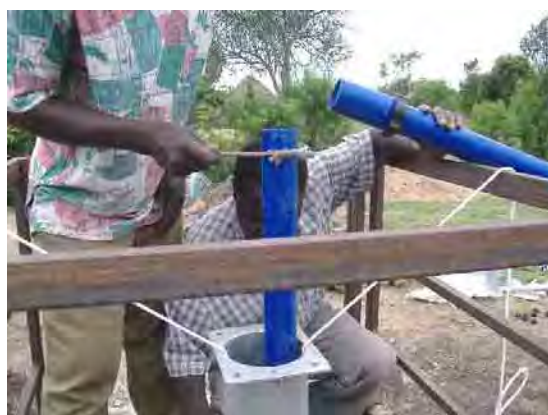
12. ポンプの据え付け
