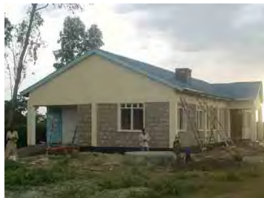
16. 外壁のペンキ塗り工
