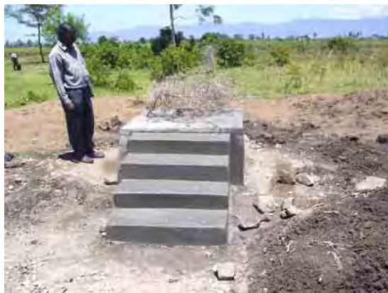
10. 完成した高台
