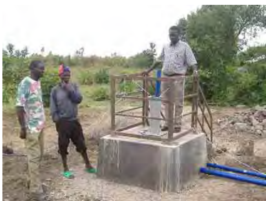
11. 手すりの据え付け
