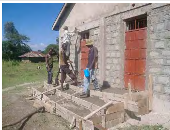
14. 階段部の工事
