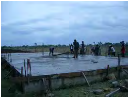
7. 基礎部へのコンクリート工
