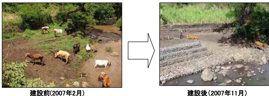
図 4.9 コミュニティによる護岸施設
