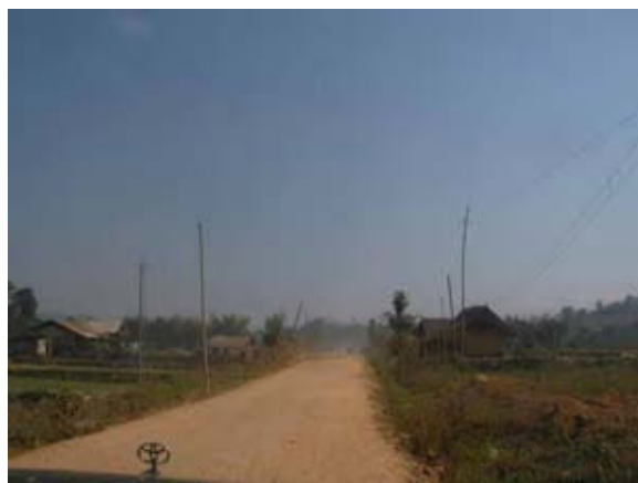
サヤブリ県ナタン村へ向かう道。悪路が続く
