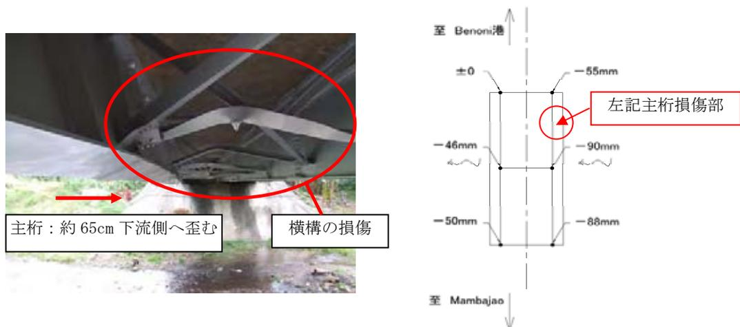
図 R 3-2.5 橋梁損傷状況
