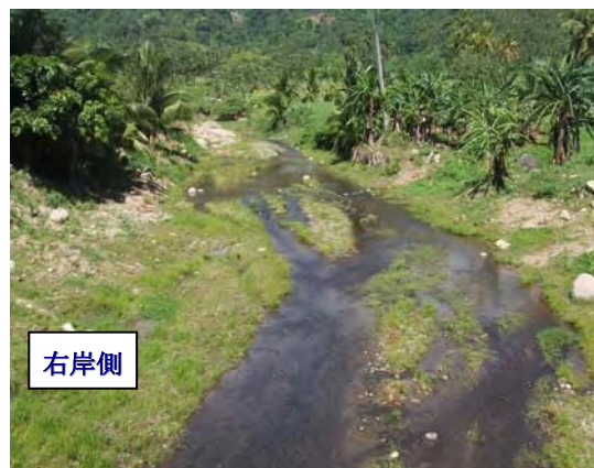
写真-4：フバンゴン川河川状況（上流）。架橋位置から約 10m 付近で右岸側に大きく蛇行している。
