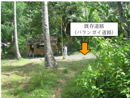
写真-3 : 上流側維持管理道路(既存舗装道路接合部)
