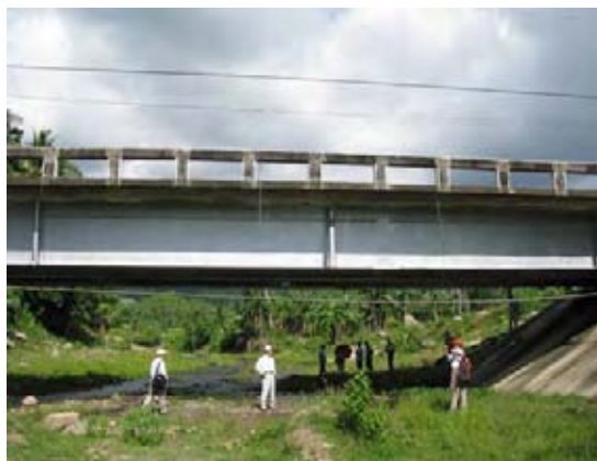
写真-1：フバンゴン橋全景（下流側から）
