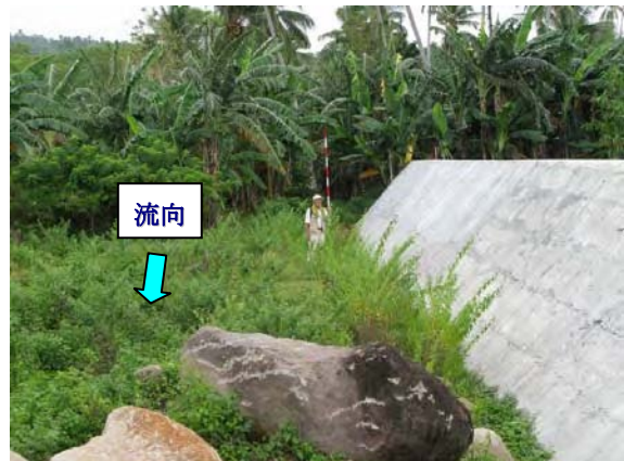
写真-6 : 自助努力により建設された洪水対策（導流堤）。基本的には土石流対策ではない。
