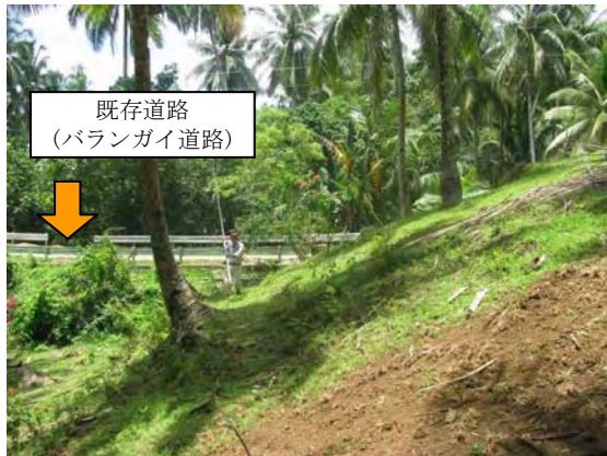
写真-1 : 下流側維持管理道路(既存舗装道路接合部)
