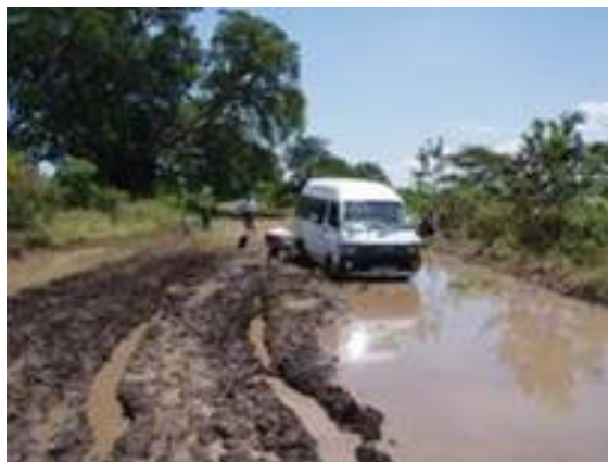
洪水により被害を受けた未舗装道路。
