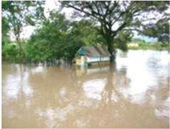
洪水により床上浸水となった住宅。
