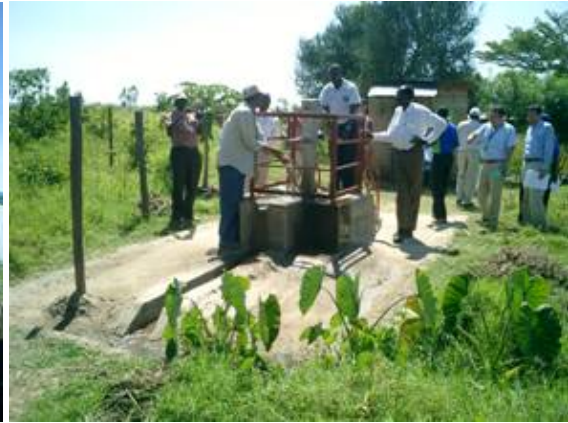
MP 調査のパイロット事業により建設された井戸。洪水時にも使用できるよう手押しポンプを地上高 1.2m としている。
