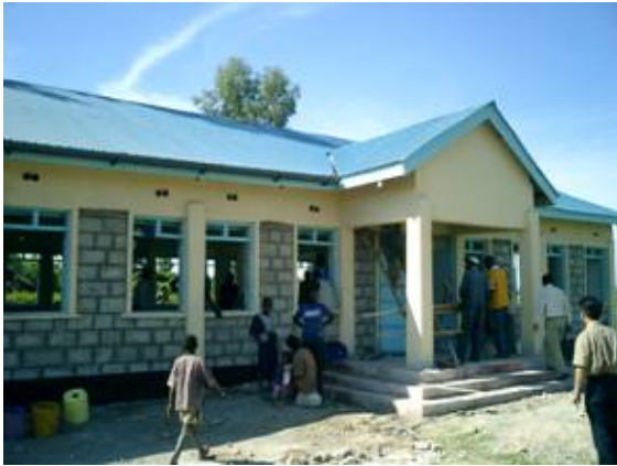
安全な避難場所の確保を目的として、ニヤンド川流域統合洪水管理計画調査（MP 調査）により建設された避難所。
