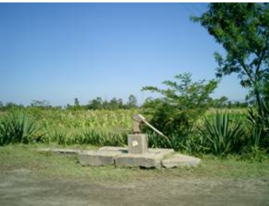
塩害により使用されなくなった浅井戸。 洪水時の安全な水源の確保が求められている。
