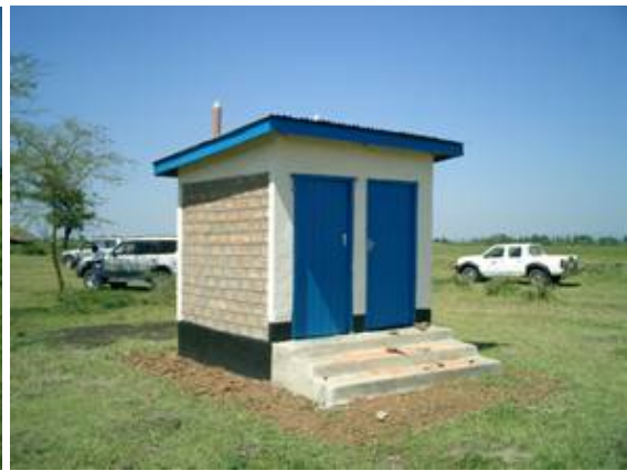
洪水時の避難場所の生活環境の改善を目的として、MP 調査のパイロット事業により建設されたトイレ。
