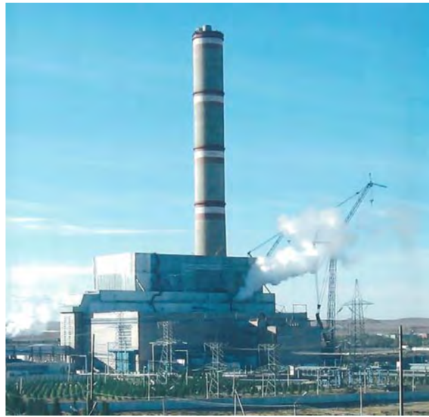
図 1-5-10 タリマルジャン発電所
