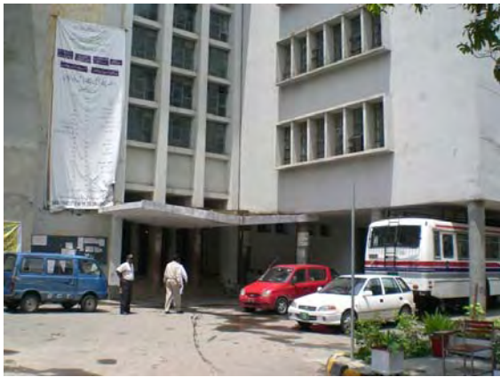
GCT Railway 正面エントランス
