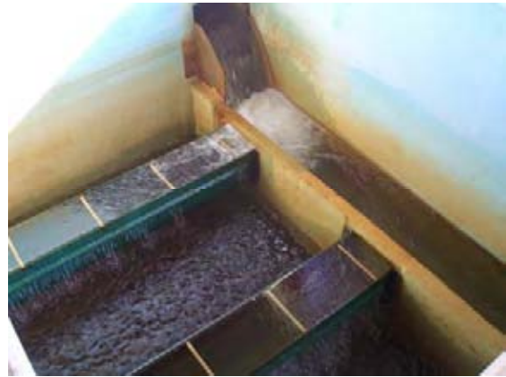
浄水場（ろ過池）
