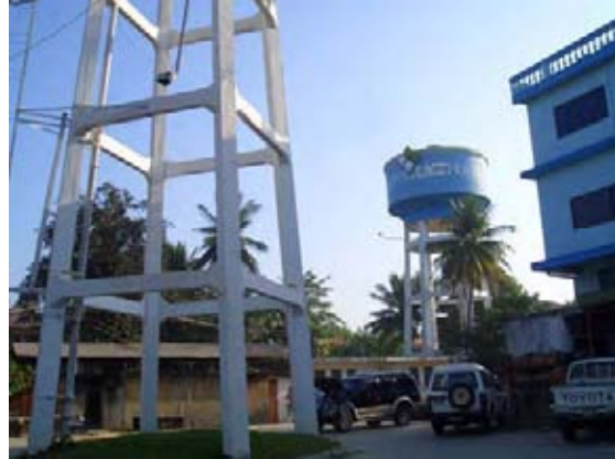
旧浄水場の高架水槽
