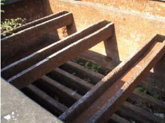
休止している旧浄水場
