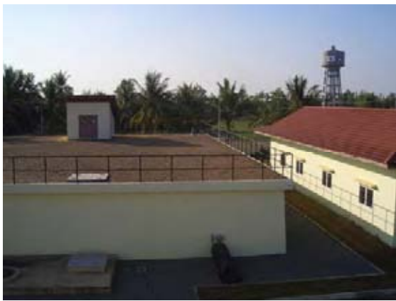
浄水場（浄水池及びポンプ場）
