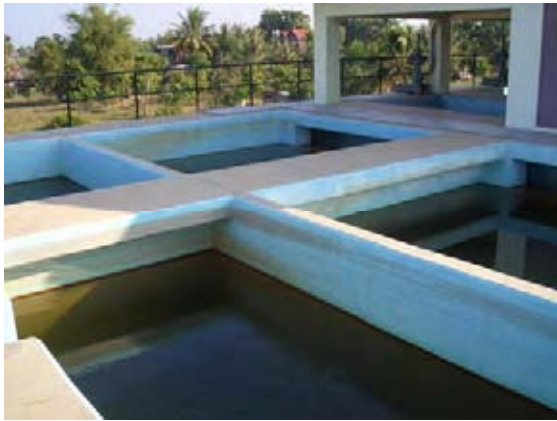
浄水場（酸化池）
