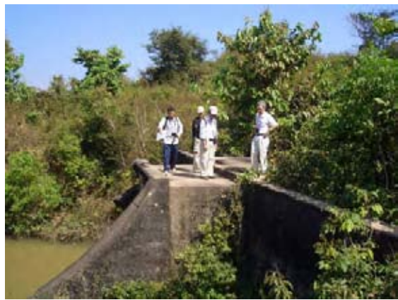
現地調査（西バライにつづく水路にある古くなって使われていない堰、2009.1.18）
