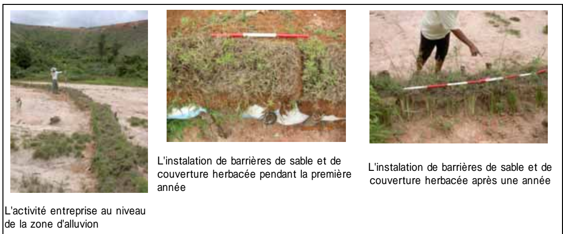
Figure D-3.4 Exemple des travaux simples pour la conservation des eaux et sols à l'éventail alluvial
