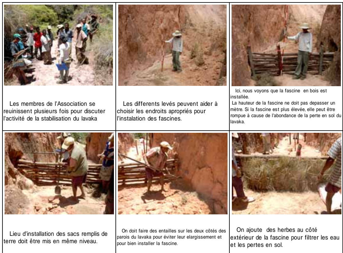
Figure D-3.3 Exemple des travaux simples pour la conservation des eaux et sols à la sortie de Lavaka (1/2)
