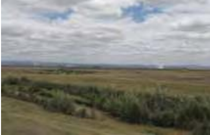
堆砂・植生繁茂が激しい排水路
