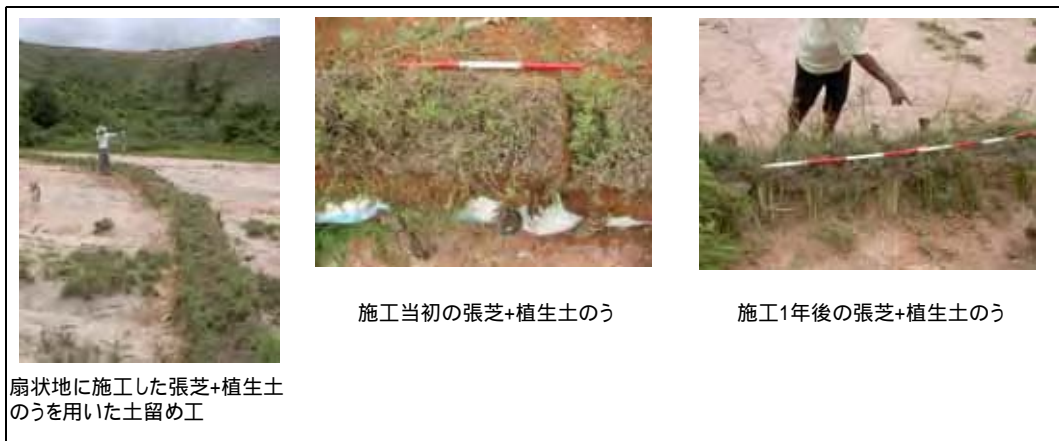
図 D-3.4 扇状地での簡易治山工事の例
