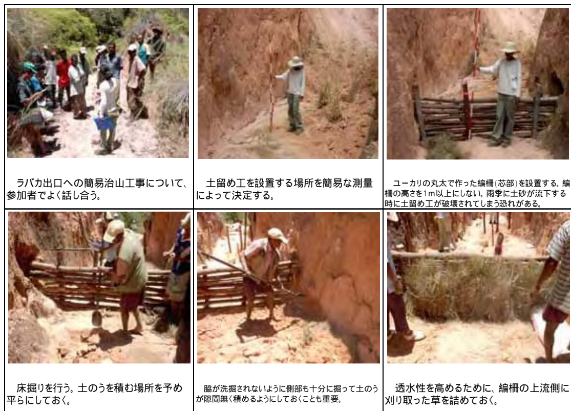
図 D-3.3 ラバカ出口の簡易治山工事の例 (1/2)
