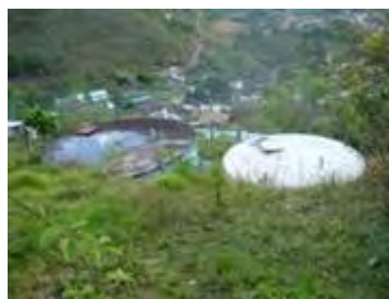
Tanque reservorio en Leymebamba
