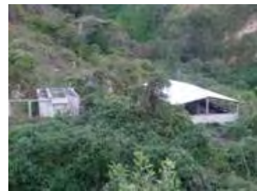
Tanque Tipo Imhoff para tratamiento del alcantarillado en Leymebamba
