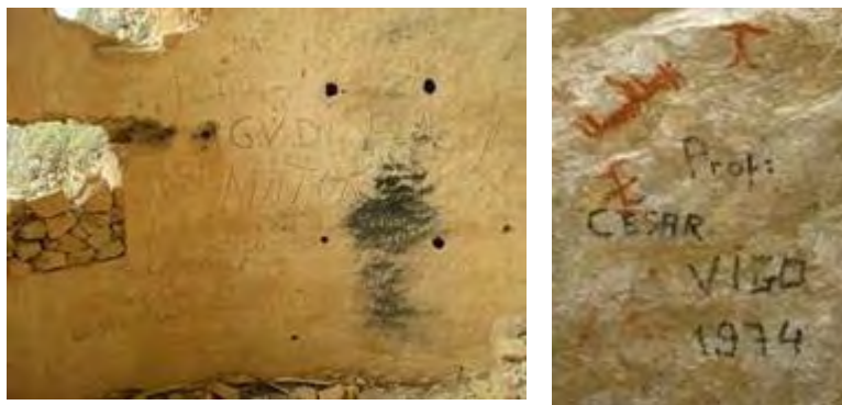
Figura 2.5 Señales de Vandalismo (Izquierda: Pueblo de los Muertos, Derecha: Revash)
