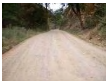
Camino Afirmado (afirmado) entre Leymebamba y desvío a Chachapoyas
