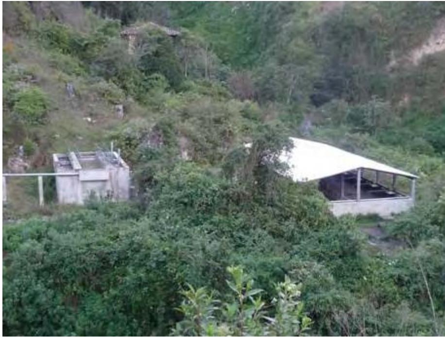
Planta de Tratamiento de Desagües – Tanque Imhoff – Lecho de Secado
