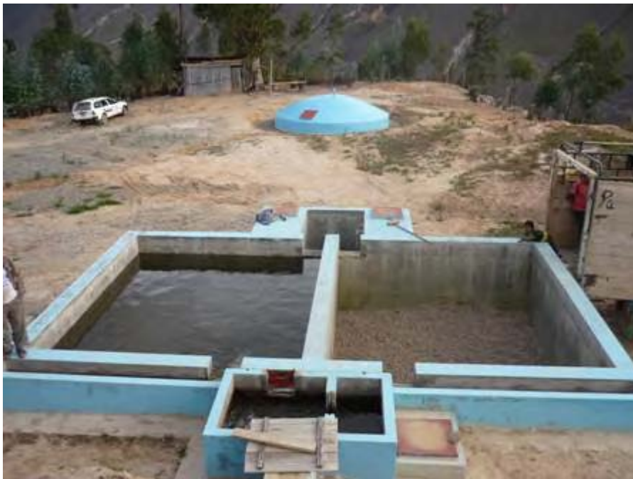
Planta de Tratamiento de Aguas – Filtro Lento
