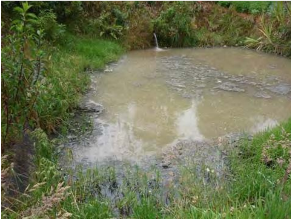
Planta de Tratamiento de Desagües – Laguna de Oxidación
