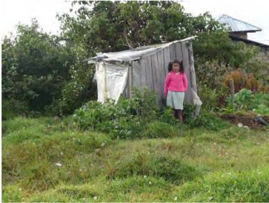
Construcción precaria de letrinas
