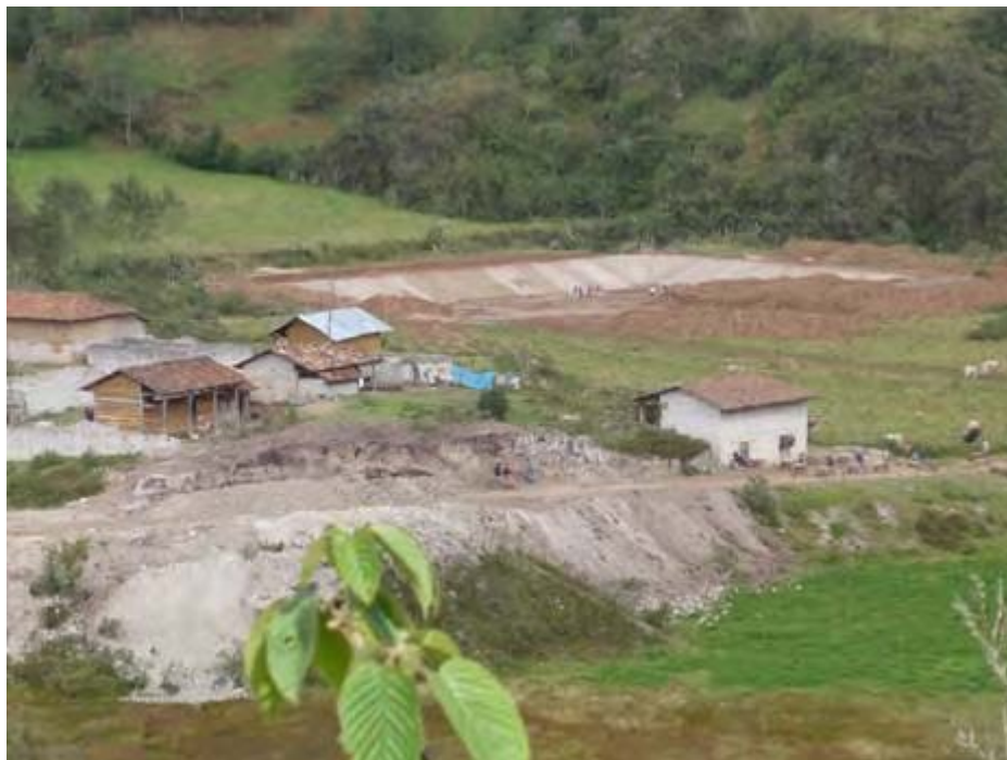
Planta de Tratamiento de Desague – Laguna de Oxidación en construcción
