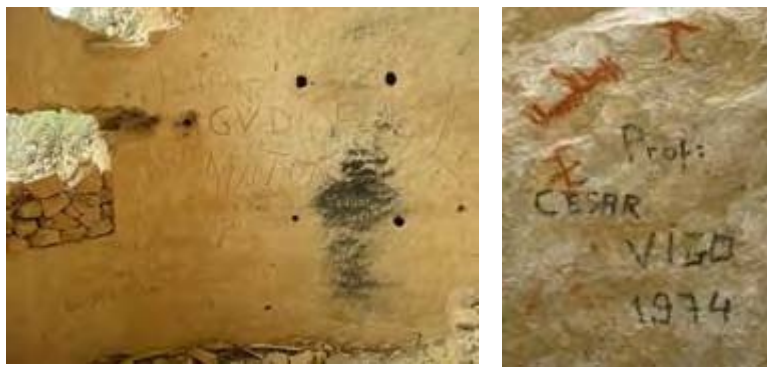
Figure 2.5 Traces of Vandalism (Left: Pueblo de los Muertos, Right: Revash)
