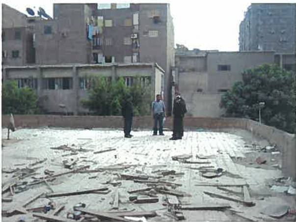
(Site 2) 既存建屋屋上の状態
