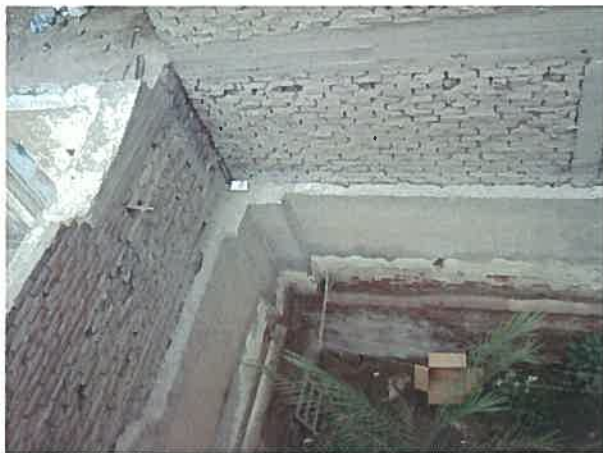
(Site 2) 既存建屋屋上から南側隣地との境界壁を見る (1) 既存建屋からの離隔距離は約4.0m
