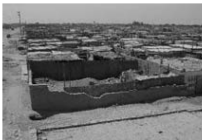
Foto: Vista de las viviendas destruidas, Pueblo Nuevo. Agosto 2008
