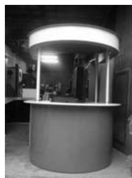
Foto: Construcción del Kiosco, Agosto 2008
