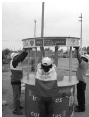
Foto: Instalación de Kiosco, Independencia. Octubre 2008.
