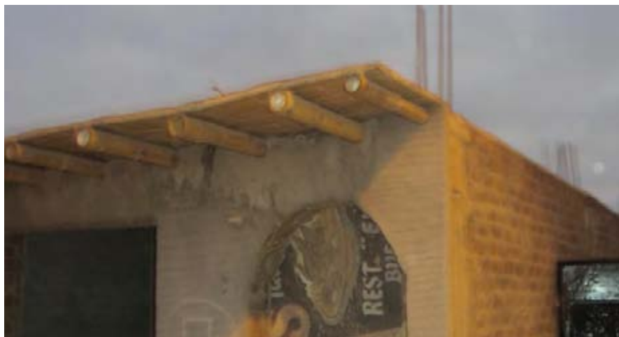
En el techo de la vivienda se muestra las cañas guayaquil, la caña chancada y la torta de barro
