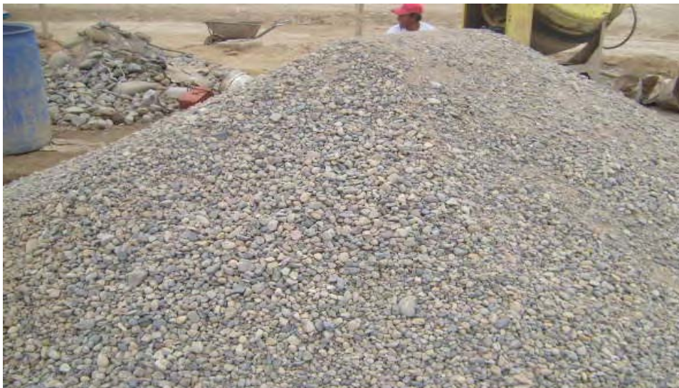
Piedra chancada en estado limpio
