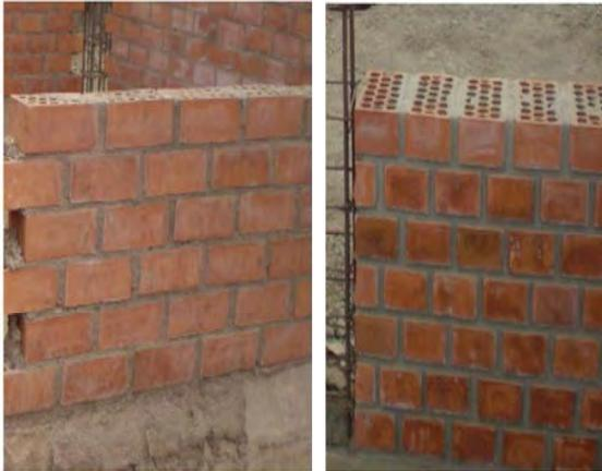
**15.-** Verificar que los muros sean de soga (con los huecos o ranuras hacia abajo y a lo largo) o de cabeza (con los huecos o ranuras hacia abajo y a lo ancho)
