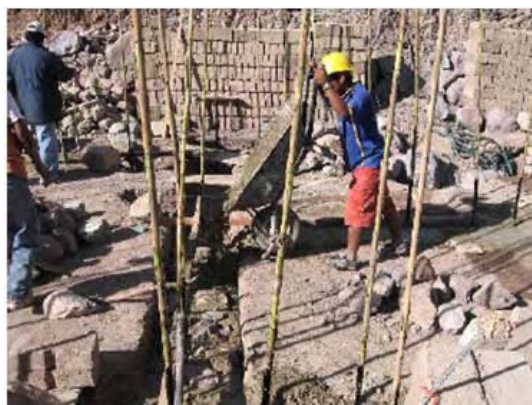
Vaciado de concreto para cimentación
