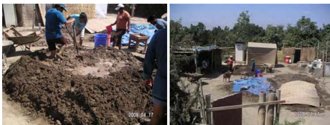
Figura 3.3.2 Capacitación para construcción de casa en adobe reforzado en Grocio Prado
