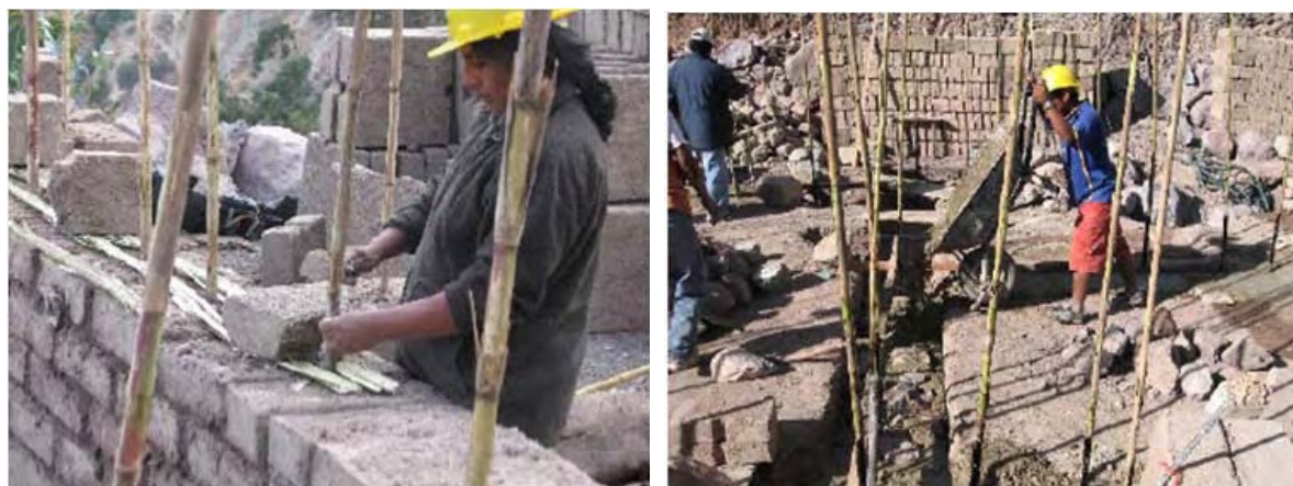
基礎のコンクリート打設
