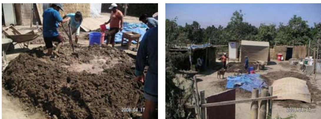
図 3.3.2 Grocio Prado 区の補強アドベ住宅建設の研修
