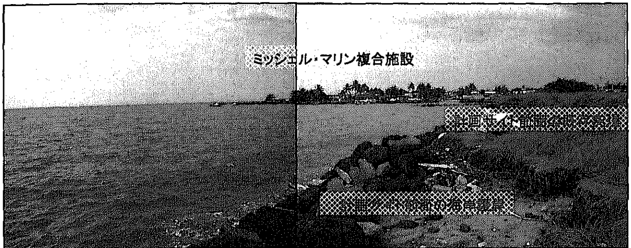
写真-2 計画サイトから河口先のミッシェル・マリン複合施設を望む
