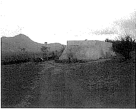
配水タンク (タラファル)
