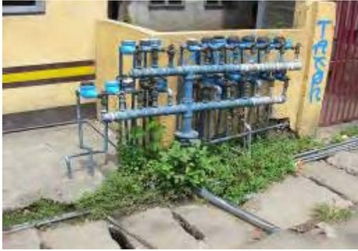
P-23:無収水削減対策の一環として実施されている Stub-out 方式による給水メーターと給水管
