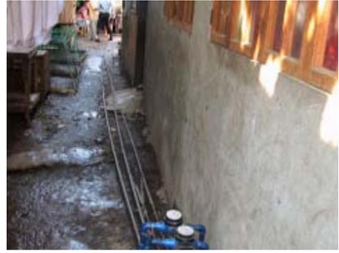
P-24:貧困住宅街の Stub-out 後の給水管布設状況
