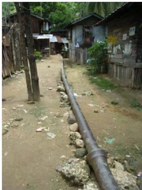
タリサイ市バラングイ・カンドラワン(Candulawan)の共同水栓を見学。MCWDの給水が届いていない山間地域で、市が近くの河川の源泉(湧水地)に取水堰を作り、地域の水場まで 200m 程度の水道管を敷設している。維持管理費として、3ヶ月ごとに 20 ペソがバラングイオフィサーにより集金しているが、支払い状況がよくないため、市が中心になり運営・維持管理をしているという状況である。利用者の話では、生活用水としてのみならず、飲料水としても利用している。また、各戸給水は便利であるが、共同水栓を利用する限り水道料金を支払わなくていいことを考えると、現行システムに概ね満足している。
