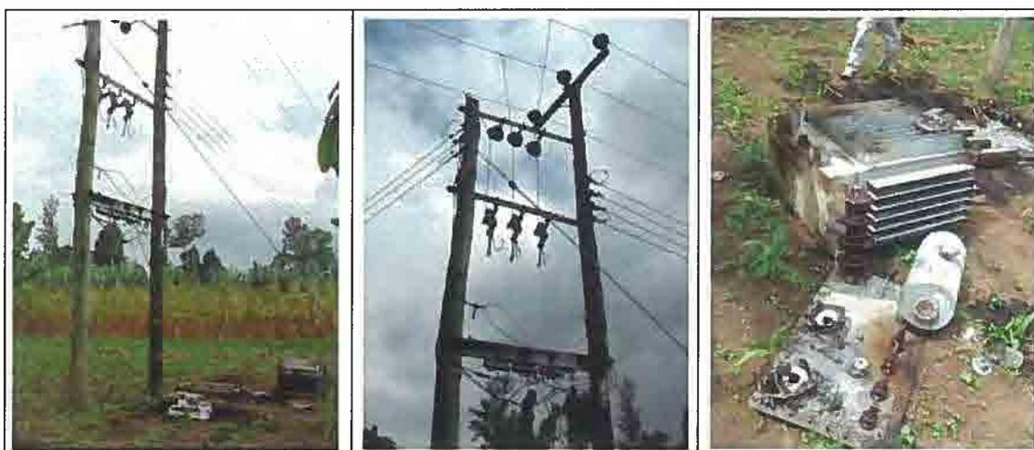
破壊された柱上トランス (11kV/400V)
