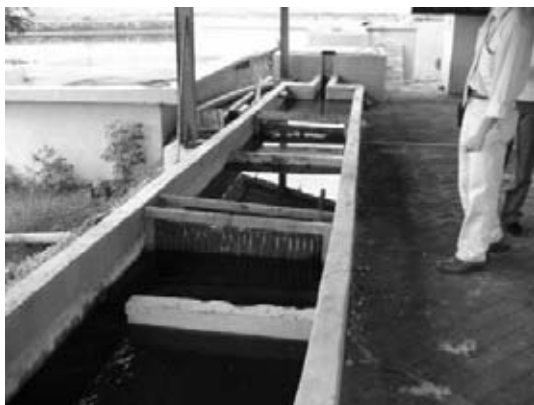
水処理プロセス（沈殿分離）
