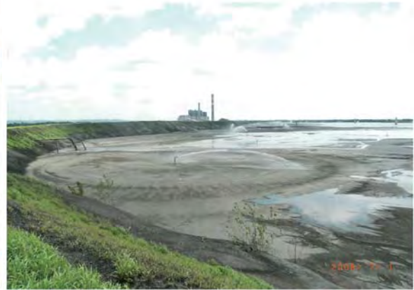
図9 褐炭灰スリ-汚泥の埋立地（池） 400ヘクタール
