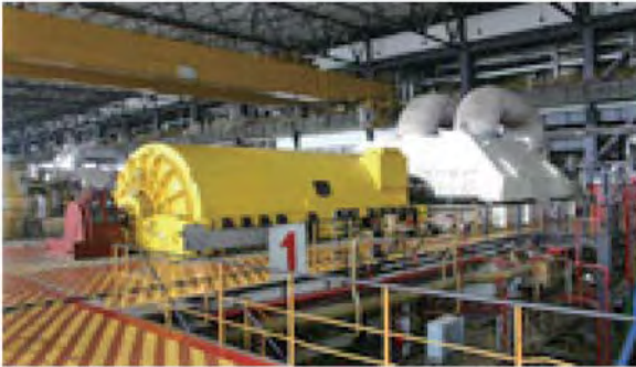
図10 1号発電機と蒸気タービンの 防音小屋
